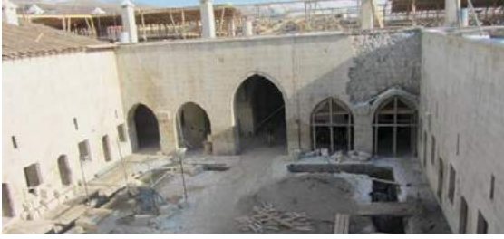
Mama Hatun Kervansarayı Restorasyon Görüntüsü
