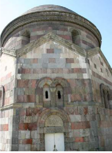
Emir Saltuk Kümbeti Kuzey Cephe
