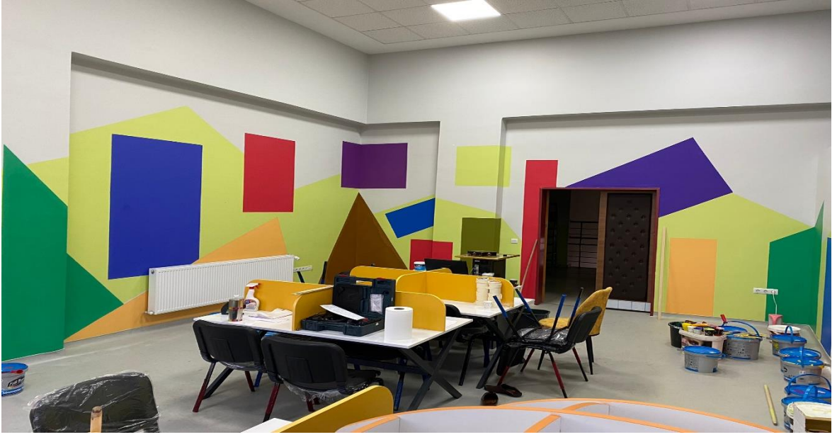
Kütüphanenin Ana Bölümünün Son Kontrollerin Yapılması
