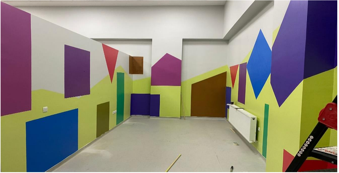
Kütüphanenin İkinci Bölümünün Kontrollerinin Yapılması
