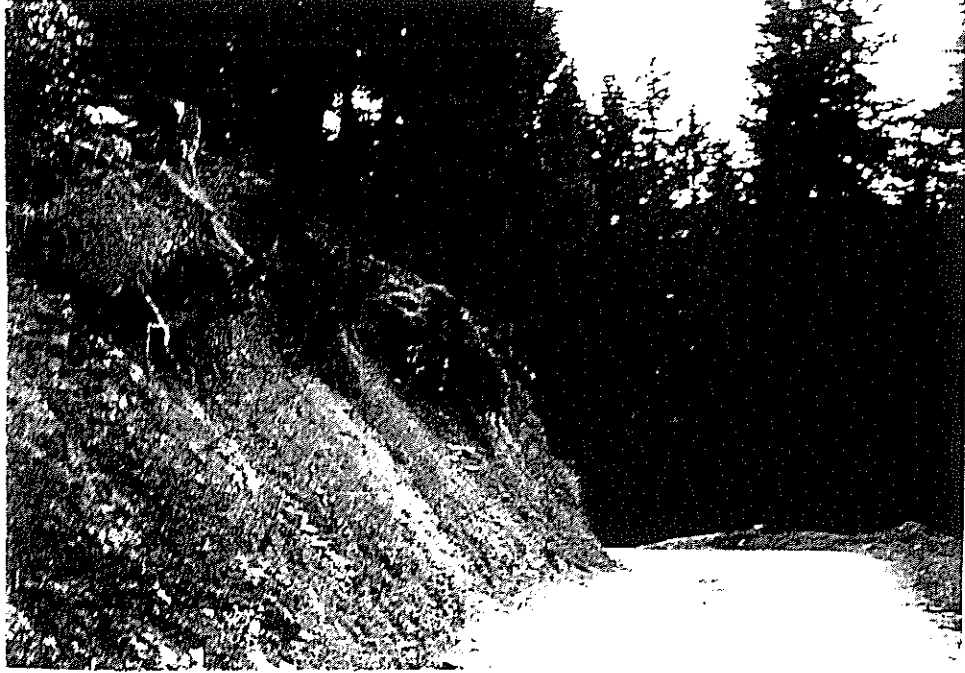
Fotoğraf 2.15. Yörede Yolların Yapımı Esnasında Eğimli Yamaçlara İstinat Duvarı Çekilmemesi Sonucunda Yaşanan Erozyon Hızlanmış ve Orman Örtüsü Gerilemeye Başlamıştır.
