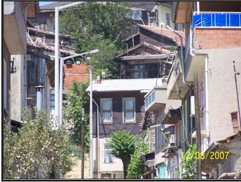
Fotoğraf 4.5. Kentin ilk yerleşime açılan mahallelerinde yapı kalitesi düşüktür (Recep Mahallesi)
