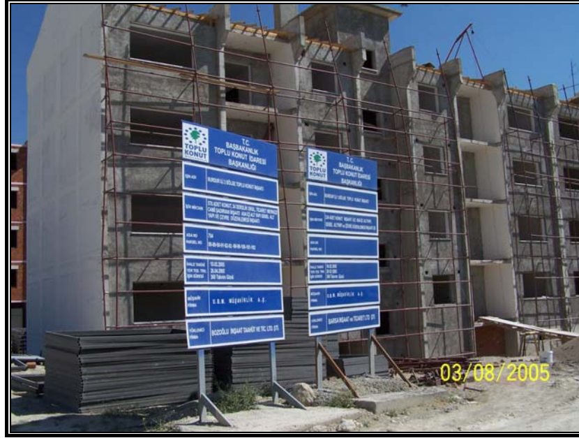
Fotoğraf 3.32. TOKİ tarafından yapılan konutların inşaatından bir görünüş.
