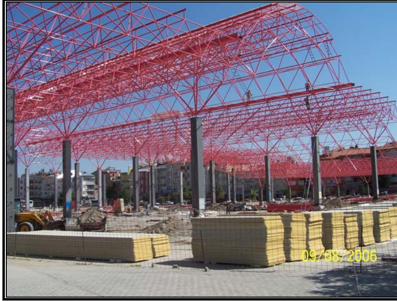
Fotoğraf 3.26. Pazar alanında uzay çatı inşaatı.
