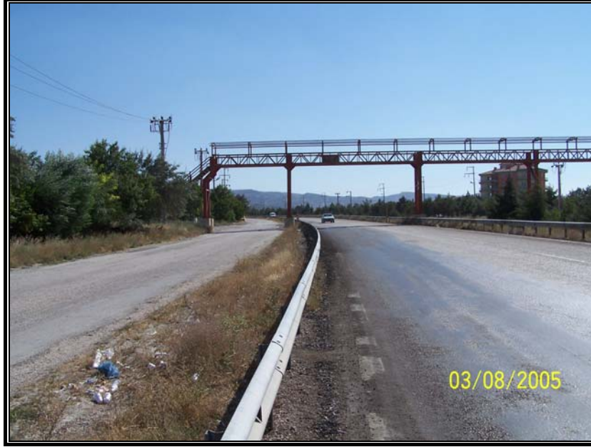
Fotoğraf 3.16. D650 karayolunun kent içerisinden geçen çevre yolu kesimi ve M. Akif Ersoy Mahallesi'ni kente bağlayan yaya üst geçiti.
