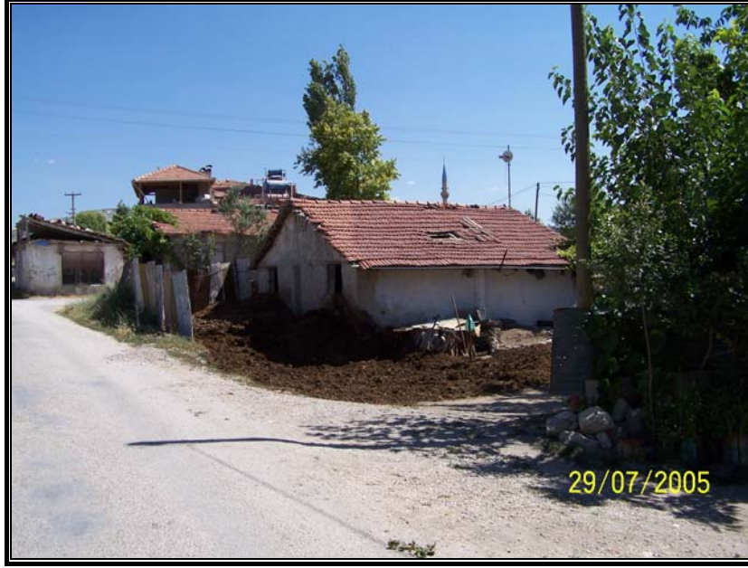
Fotoğraf 3.41. Hızırilyas Mahallesi'nde yer alan ahırlardan bir görünüş.
