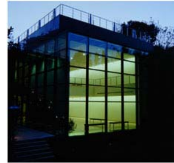
Resim 3.16 SSM- Dış Görünüm
