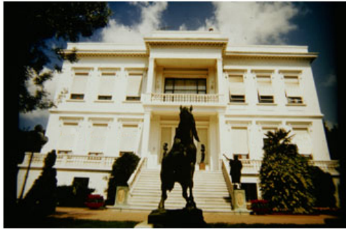
Resim 3.15. SSM- Dış Görünüm
