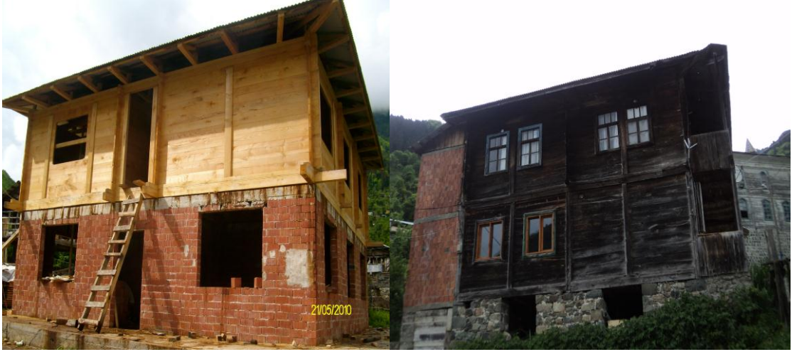
Fotoğraf 2.9. Camili’de Ahşap-Tuğla (Soldaki) ve Ahşap-Taş (Sağdaki) Malzemeler Kullanılarak Yapılan Meskenlerden Bir Görünüm.
