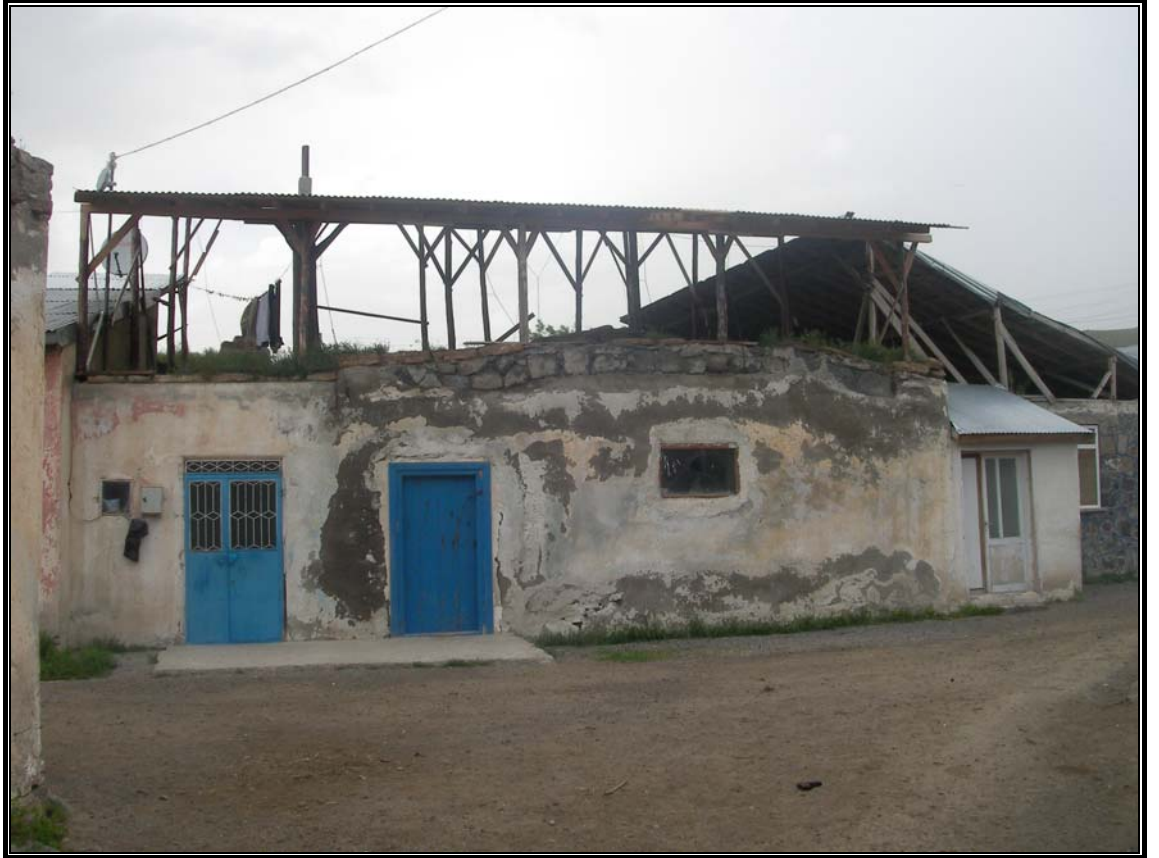
Fotoğraf 3.2. Ahşap Direkler Dikilerek Yapılan Çatı Şekli.
