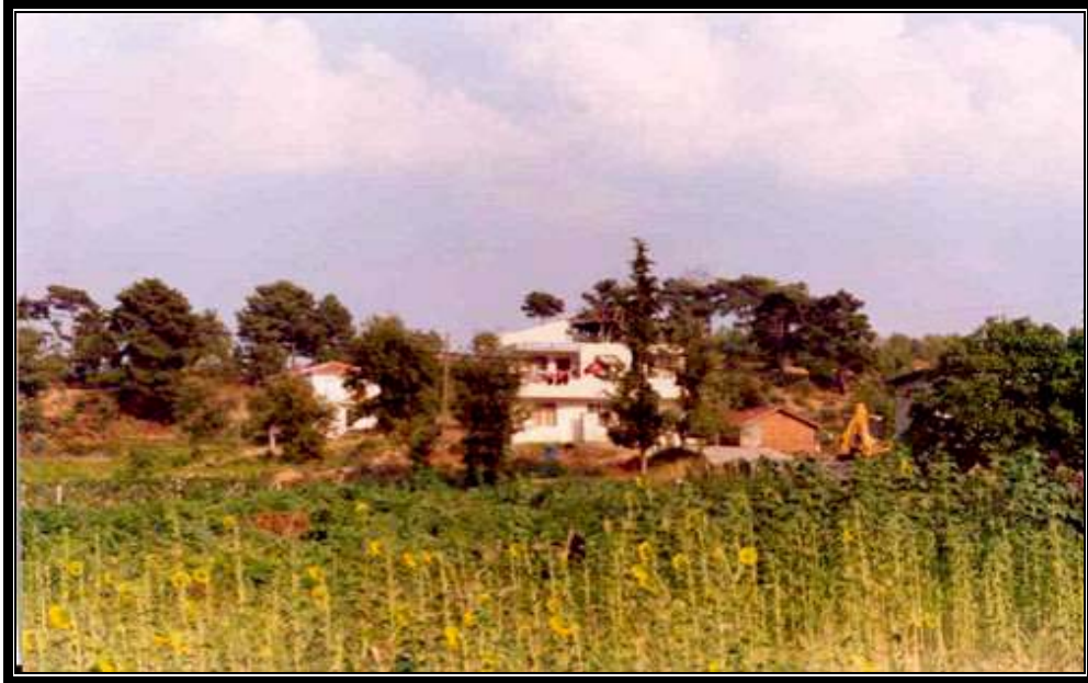
Fotoğraf 2.18. Güçlüköy Belediyesi Hizmet Binasından Bir Görünüm.
