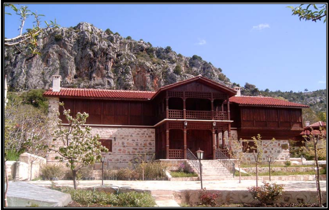
Fotoğraf 2.57. Menteşbey Köyünde Restore Edilmiş Göktepe Konağı.
