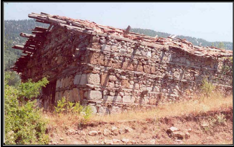
Fotoğraf 2.56. Eski Tip Meskenlerin Dış Cephesinde Ahşabın Kullanıldığı Bölümler Oldukça Fazladır.
