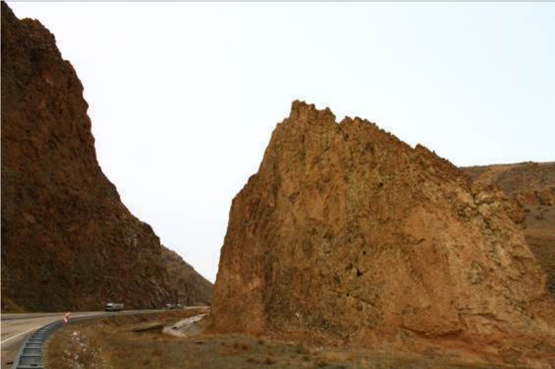
Fig.142. Dellal Kaya Basamaklı Su Tüneli
