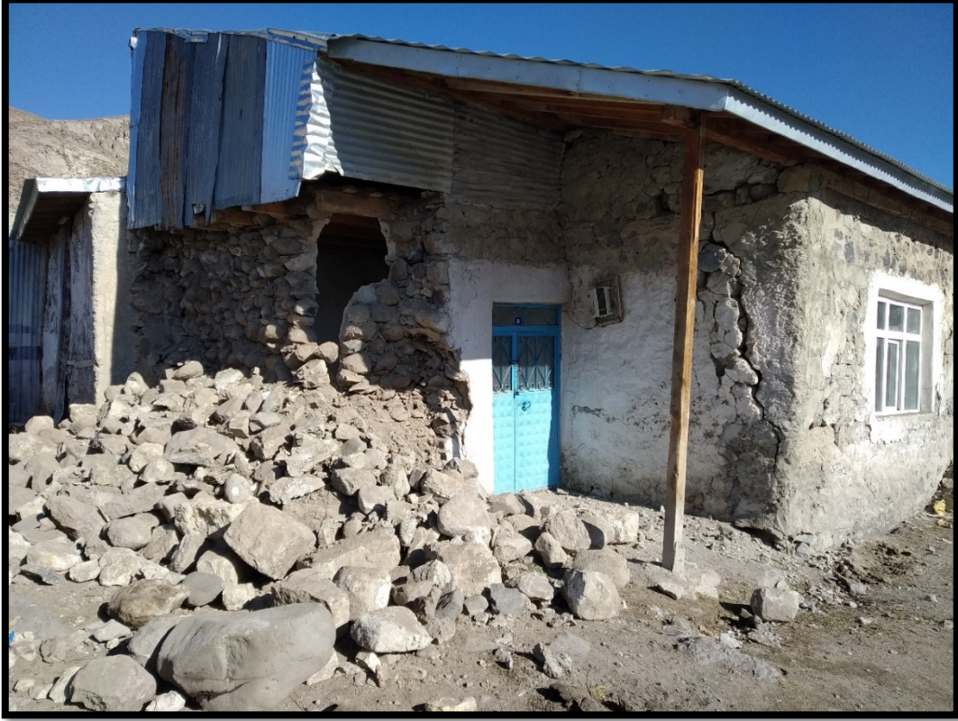
Şekil 17. Topçu Köyünde hasar gözlemlenmiş bir yapı
