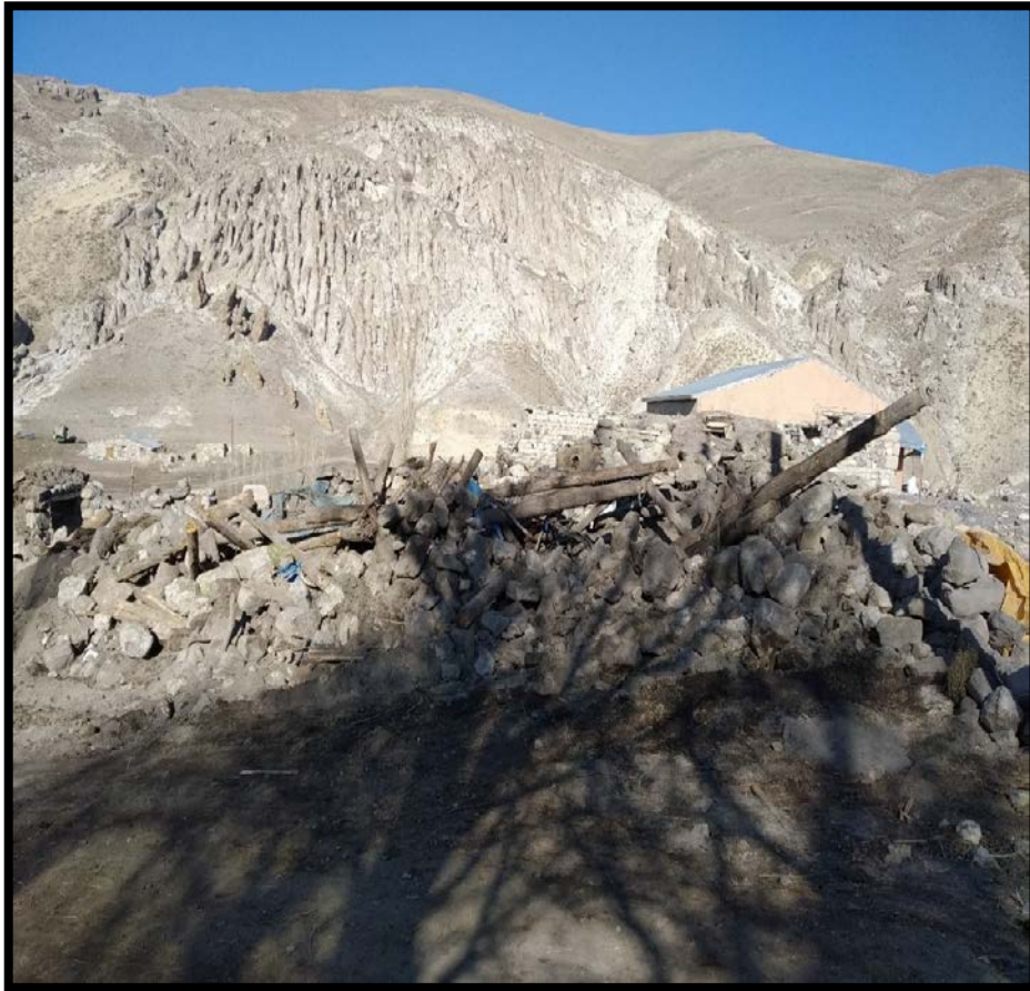
Şekil 18. Topçu Köyünde hasar gözlemlenmiş bir yapı
