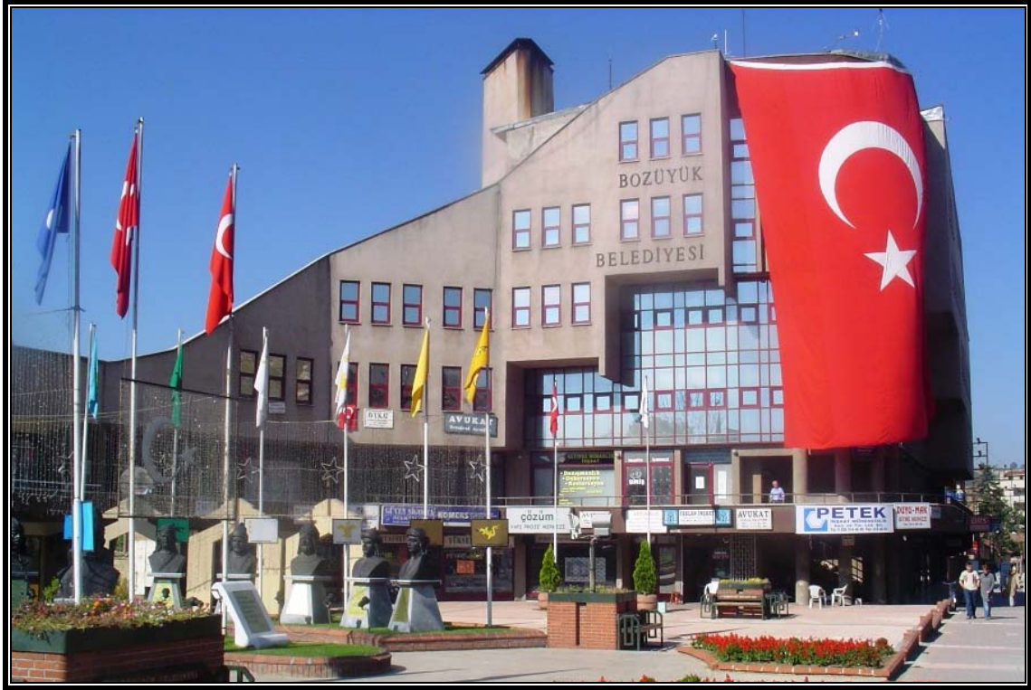
Fotoğraf 3.2. Bozüyük Belediyesi binasından bir görünüm.
