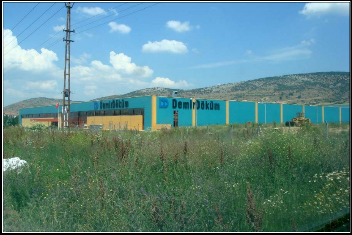
Fotoğraf 3.35. Türk Demirdöküm Bozüyük Tesisleri Su Isıtıcıları Fabrikası'ndan bir görünüm.
