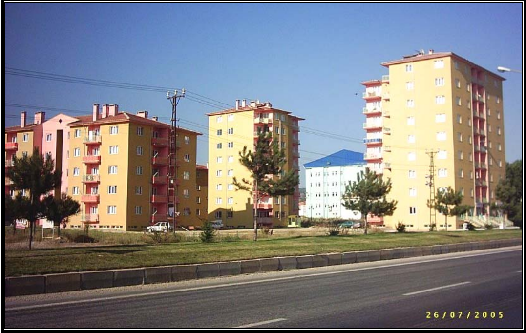
Fotoğraf 2.10. 4 Eylül Mahallesi, kentin doğusunda bulunup gelişmesi devam etmekte olan bir mahalledir. Son derece modern ve çok katlı binaların yer aldığı mahallenin doğuya doğru olan gelişimi burada yer alan fabrikalar nedeniyle engellenmektedir.
