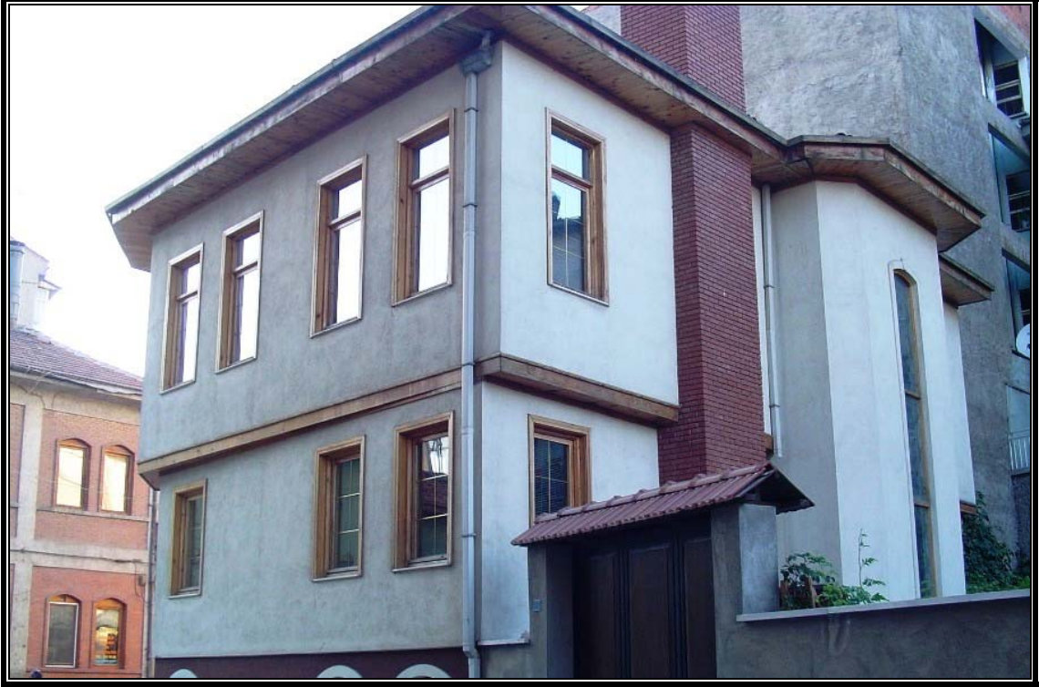
Fotoğraf 4.3. Geleneksel mimarinin en fazla görüldüğü yerler, kentin ilk yerleşim nüvesini oluşturan Kasımpaşa ile Tekke mahalleleridir. Fotoğrafta Kasımpaşa Mahallesi'nde bulunan ve restore edilmiş geleneksel bir konut görülmektedir.
