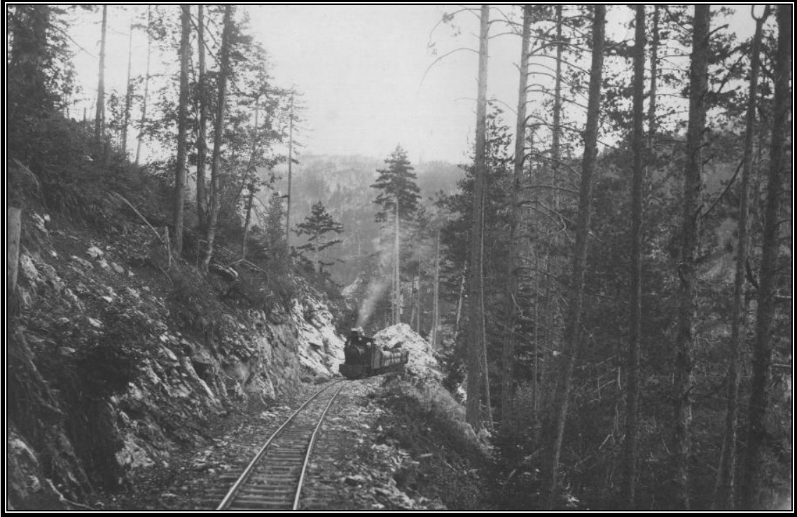
Fotoğraf 3.28. Bozüyük Kereste Fabrikası'na kilometrelerce uzaktan değişik vasıtalarla tomruk getirilmekteydi. Bunlardan biri de dekovil hattı üzerinde küçük bir lokomotif ile çekilmeye dayanan yöntemdi (Foto-Nadir Mumcu'nun arşivinden).
