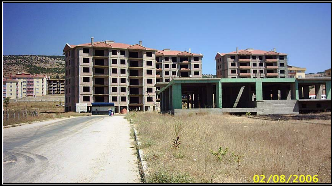
Fotoğraf 3.25. Bozüyük'ün gelişim alanında bulunan çok katlı binaların yer aldığı 4 Eylül Mahallesi'ndeki inşaatlardan bir görünüm.
