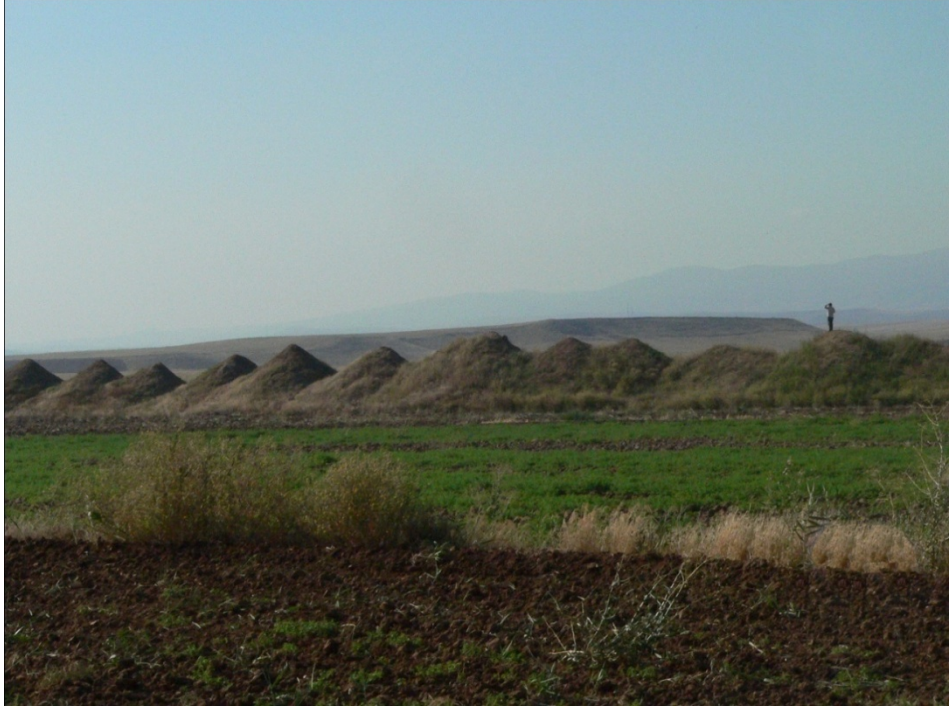
Fotoğraf 1.29. Kılıçözü Çayı Aşağı Havzasındaki Tatlıcak-Tavaözü Akarsu Boyu Ovasında Taşkını Önleme Amacıyla Yapılan Taşkın Kontrol Setleri.
