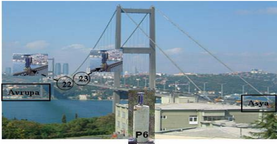
Şekil 3.17. Boğaziçi Köprüsü referans noktaları (Erdoğan vd 2009)
